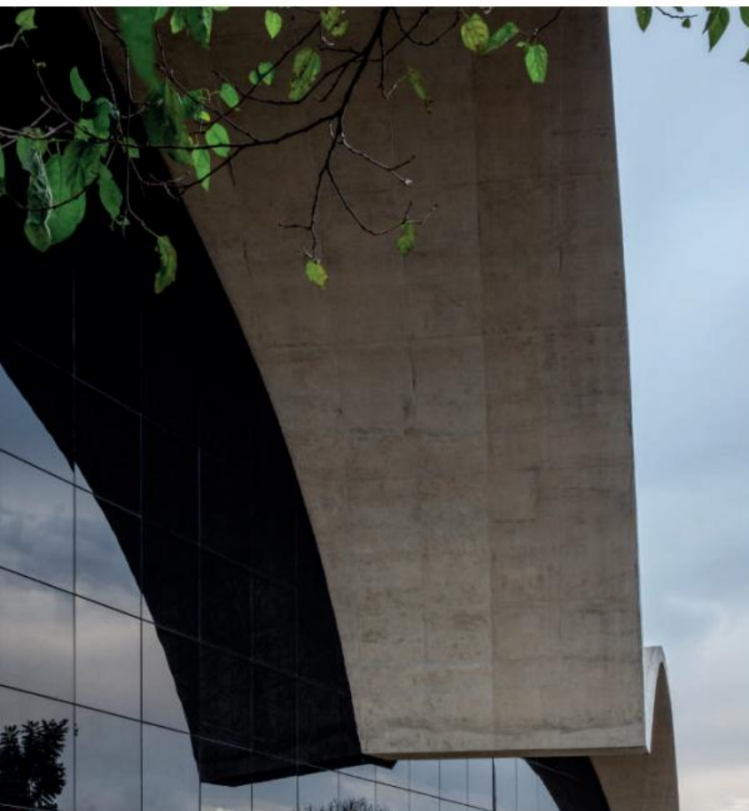
Detalhe lateral do Auditório Simón Bolívar
